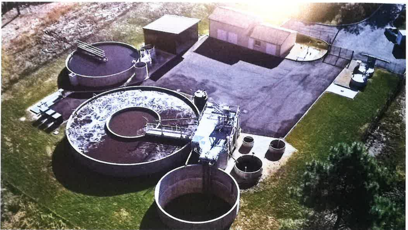
Station d'épuration de Planneaux
